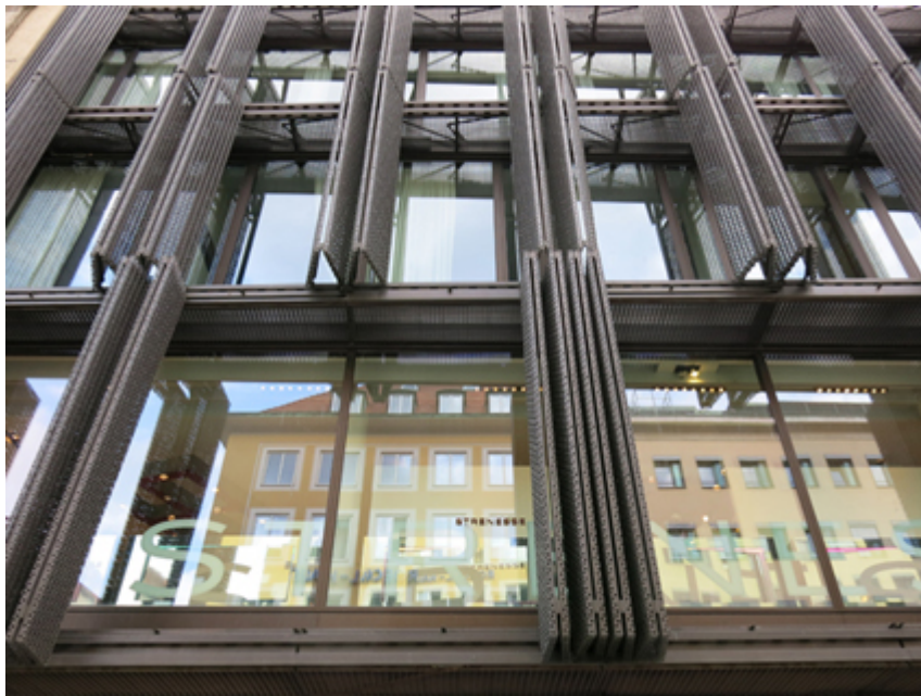
Figuur 3 3 dubbel glas en met bijzondere verticale zonwering
